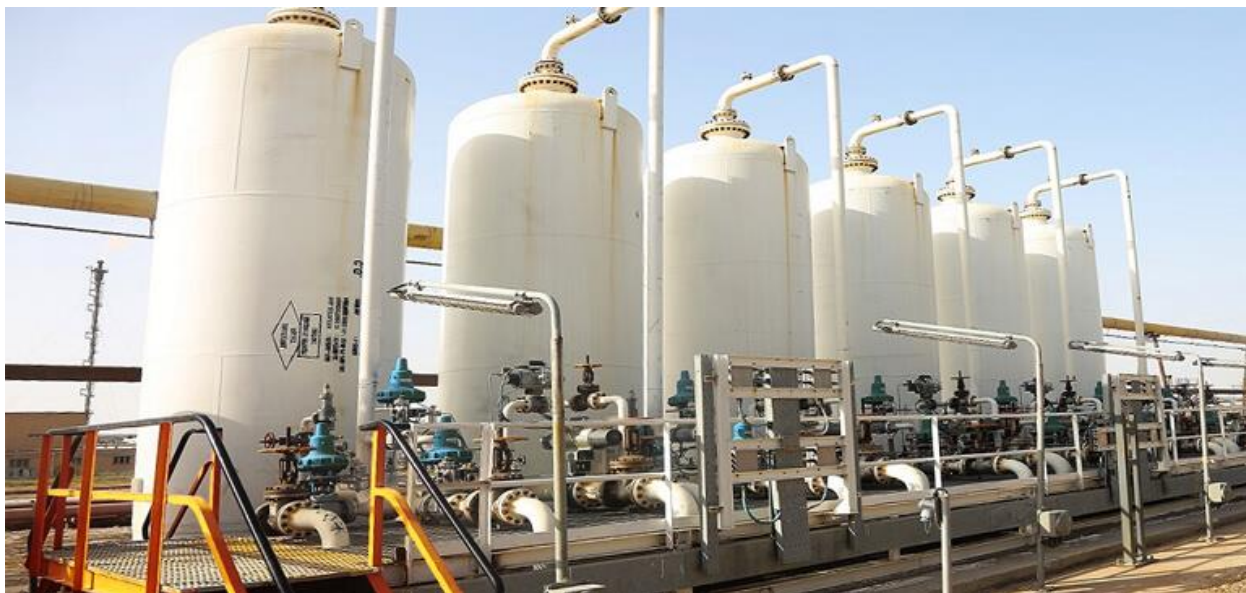
Рисунок 2 – Стандартные вертикальные адсорберы, применяющиеся в промышленности
